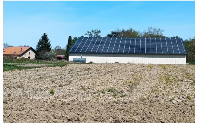
Figure 1. Les grandes toitures solaires de stabulations ou hangars sont aujourd'hui très répandues (Bâtiment agricole dans le Seignanx). Source : audap
